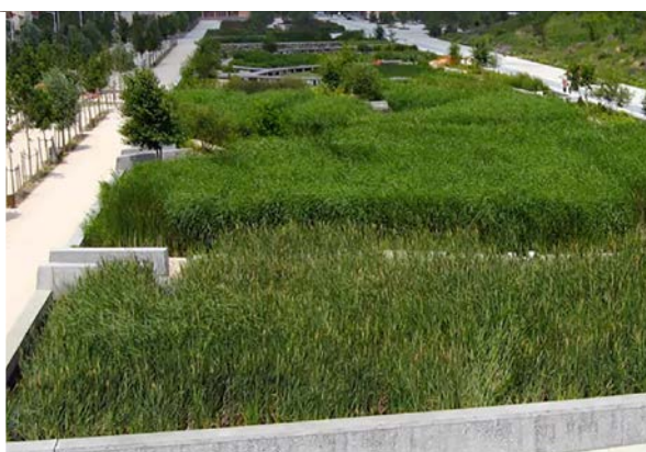
b) Phyto-purification (filtering of wastewater using plants) parc du chemin de l'île/France 105
