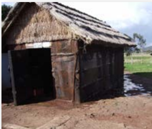
Chambre froide de stockage temporaire (Photo B. Schiffers)
