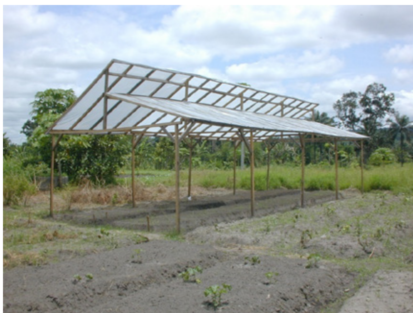
Abri de fabrication locale pour cultures maraîchères (Photo G. Delhove)
