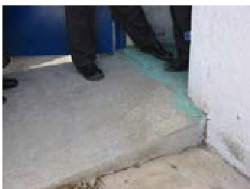
Construction d'un seuil d'entrée. Objectif : améliorer la rétention dans le local de stockage (photos B. Schiffers)
