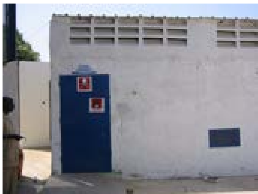
Exemple de magasin bien protégé et bien ventilé. On notera les pictogrammes de sécurité sur la porte (photo B. Schiffers).
