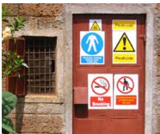
Exemple de protection des accès : fenêtre grillagée, porte verrouillée et/ou cadenassée. On notera les pictogrammes de danger apposés (Photo B. Schiffers)
