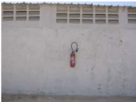
Un extincteur doit être disposé sur le mur extérieur du local de stockage (photo B. Schiffers).
