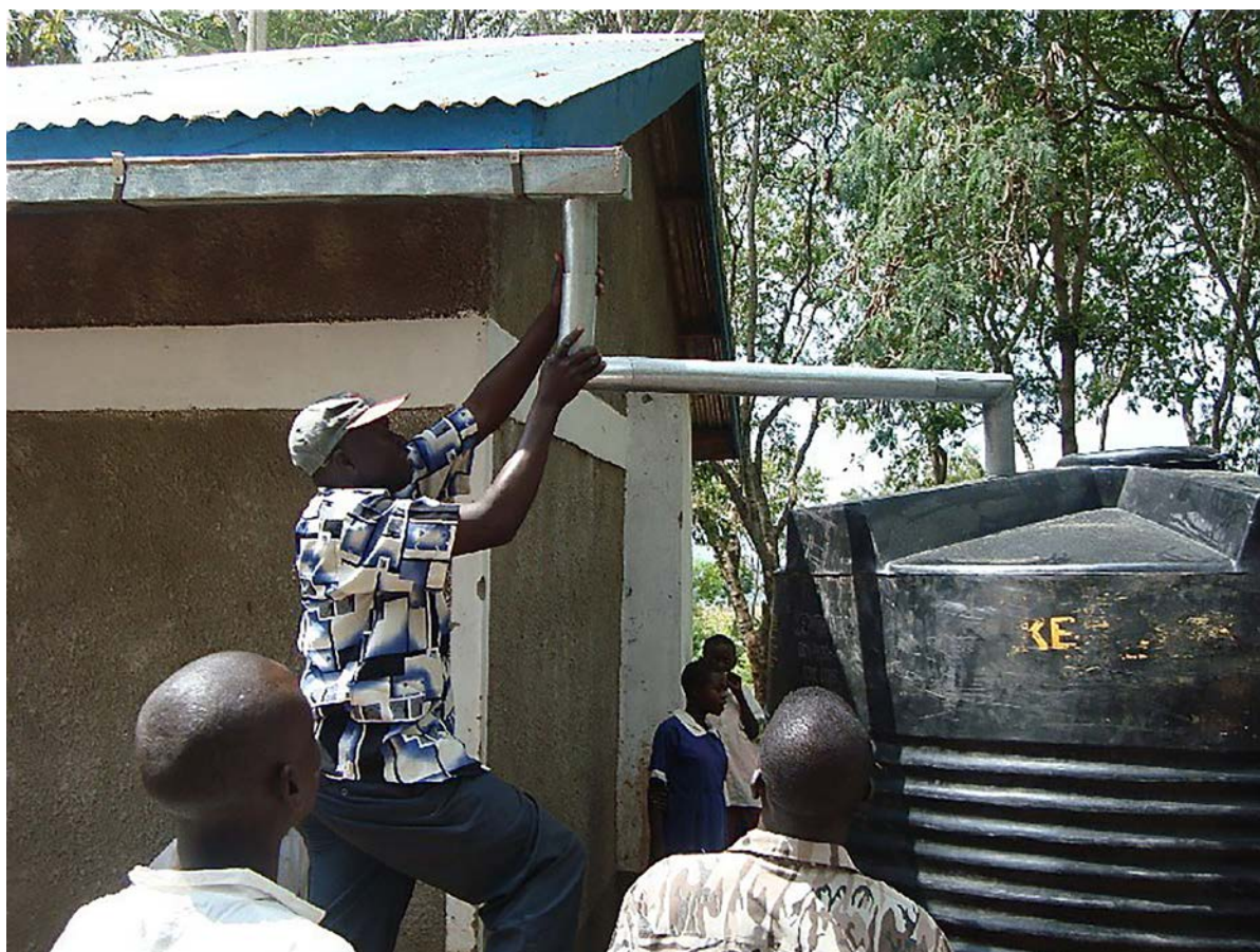
Figure 1 - Récupération simple de l'eau sur les toits 266
