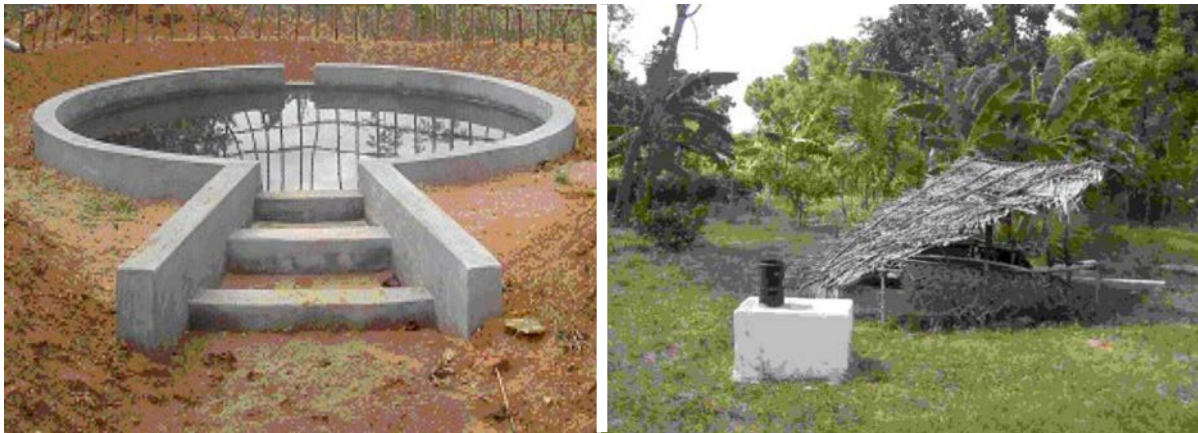
Figure 3 - Structure de collecte des eaux de ruissellement (gauche) avec toit de chaume et clôture (droite) au Sri Lanka Source : Exposé technique, récupération des eaux de ruissellement 271
