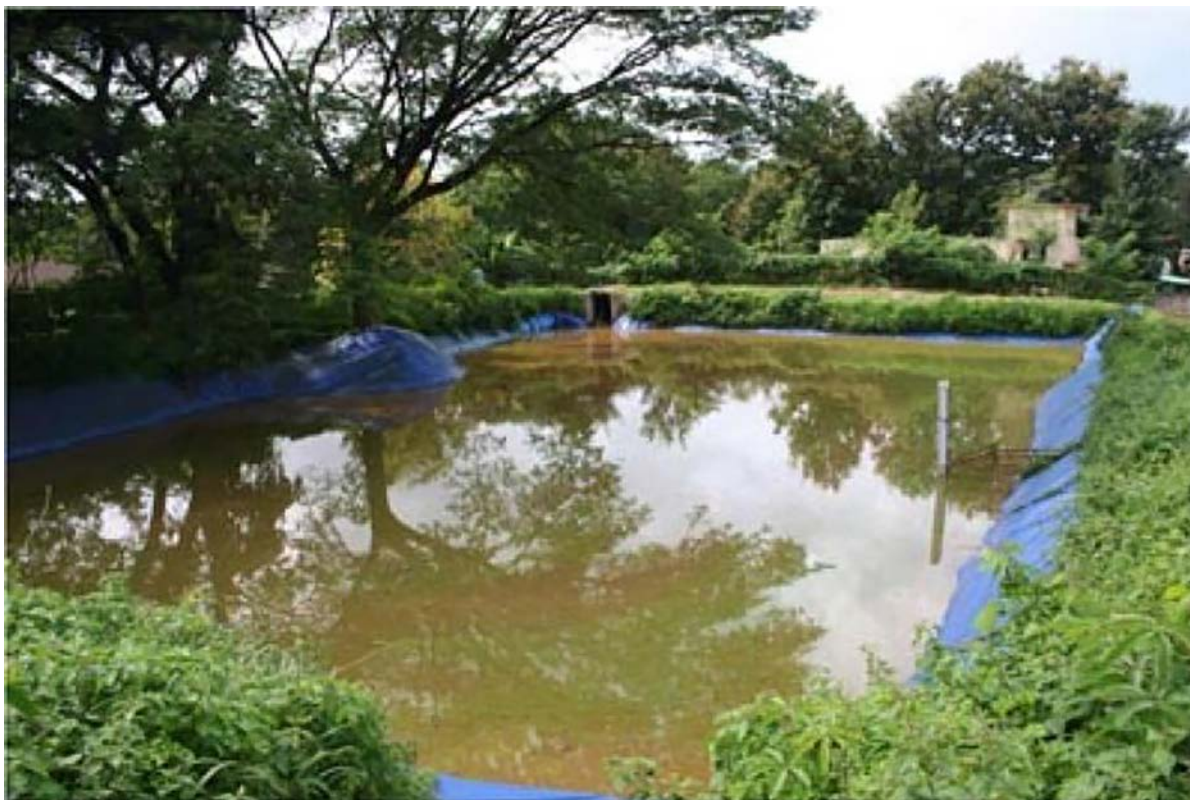
Figure 2 - Cuve bon marché pour le stockage de l'eau Source : Indian Council of Agricultural Research ( www.icar.org.in/en/node/1417 )
