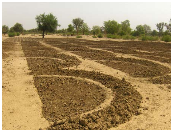
Figure 17 - Travaux communautaires: réalisation de demi-lunes
