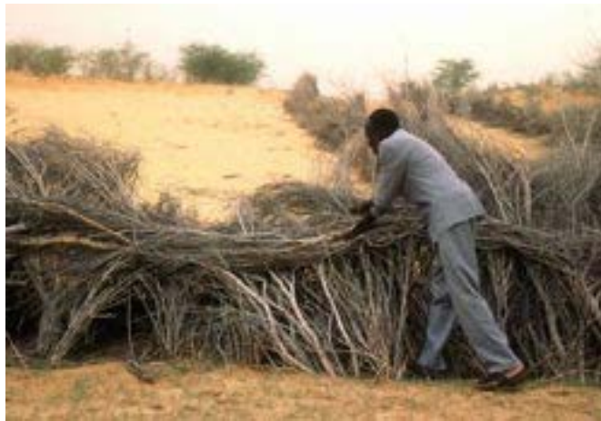
Construction de barrières pour empêcher l'avancée des dunes de sable. Les palissades sont fabriquées avec des arbustes locaux ou des palmes séchées (Photo FAO, P.Cenini).
