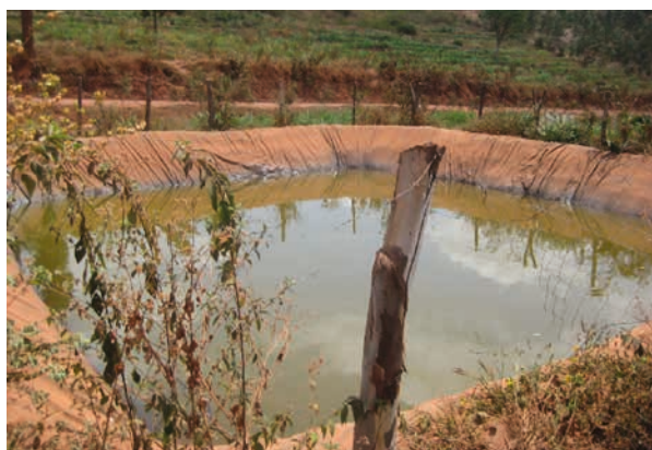
a) Collecte d'eau de pluie à Kayonza/Rwanda
