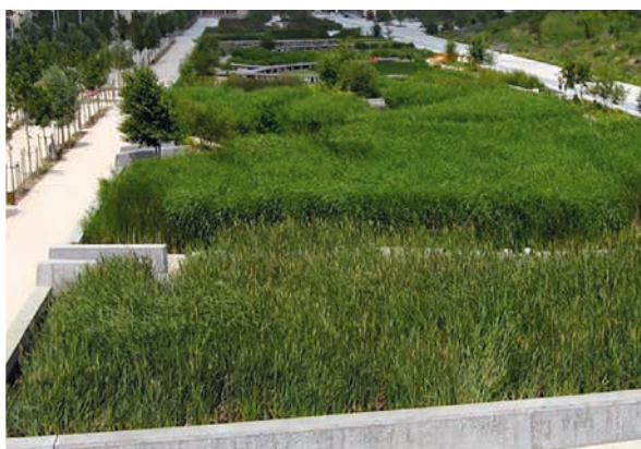
b) Phytoépuration (filtrage des eaux usées par les plantes) parc du chemin de l'île / France 103
