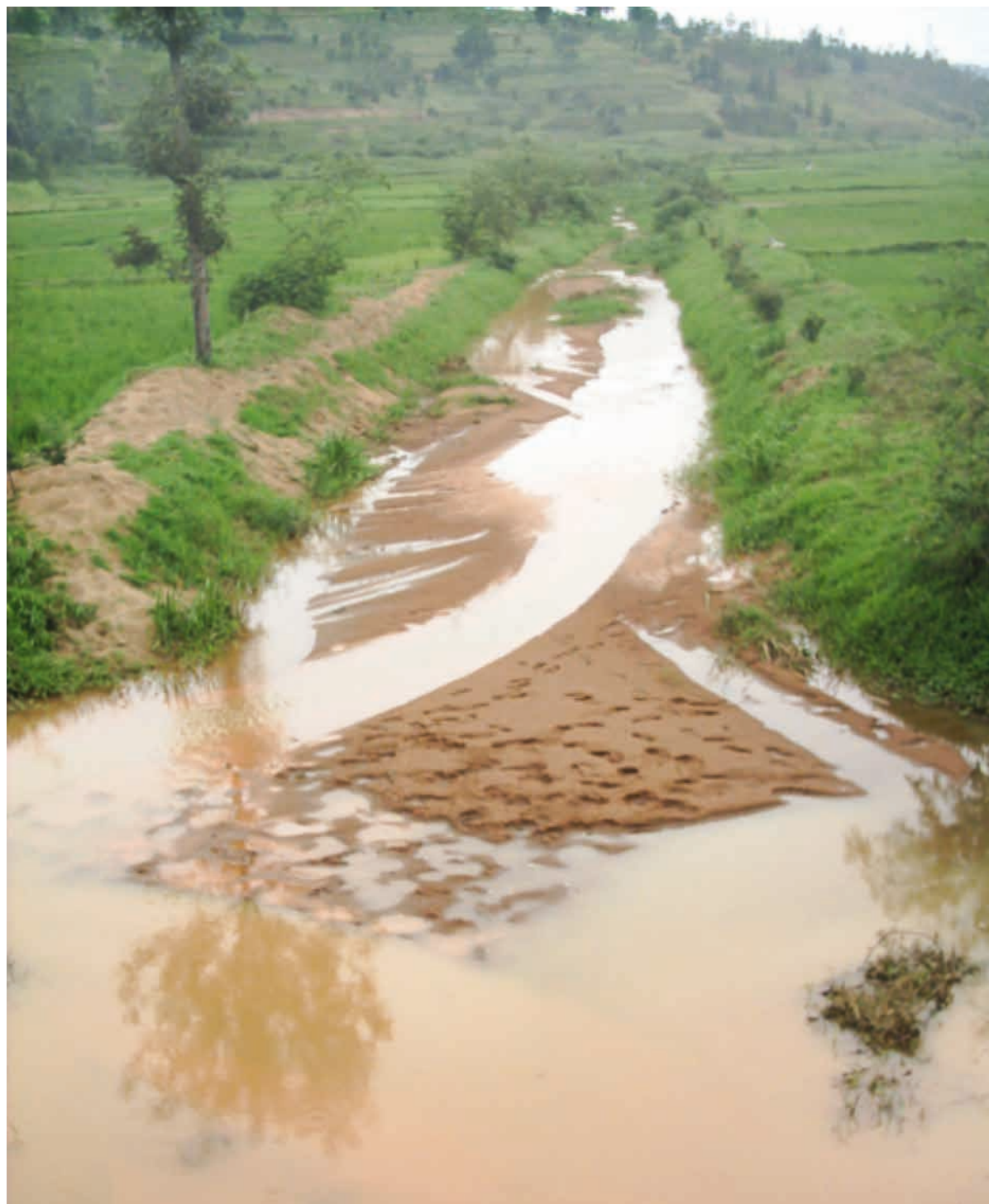
Figure 4 : Ensablement d'un bas-fond et des canaux d'irrigation et de drainage au centre du Rwanda Source : Mulindabigwi,V. 2007
