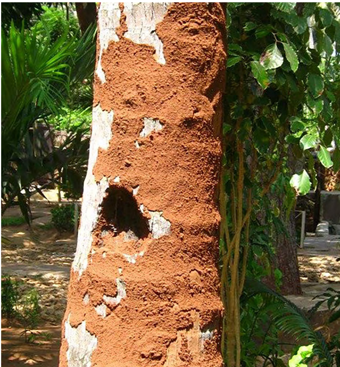
Figure 53 — Dégâts de termites sur un tronc de cocotier
